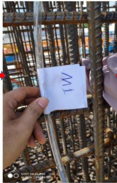
Lắp sensor và đánh dấu vị trí
