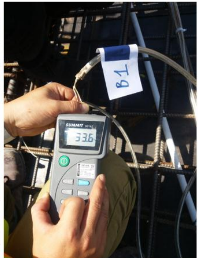
Quá trình đo nhiệt độ bê tông
