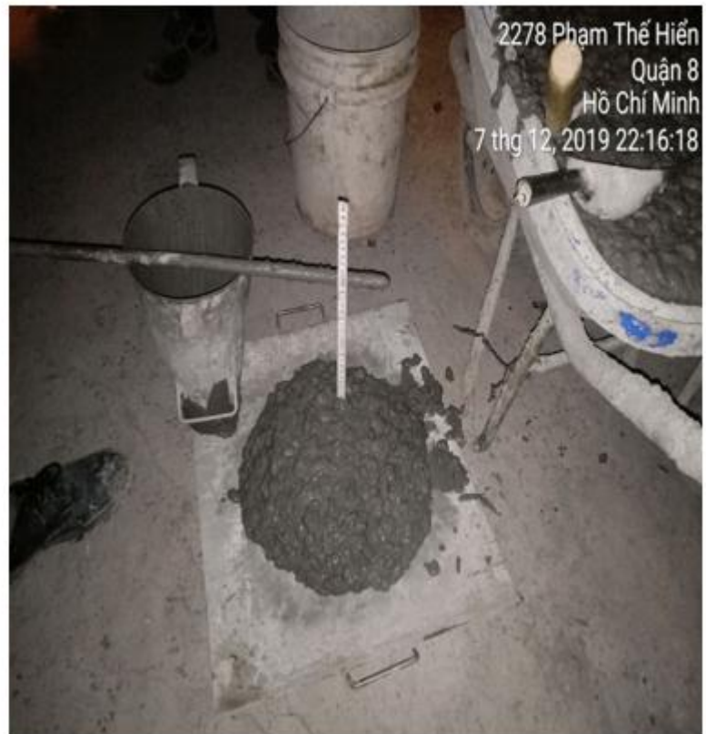
Kiểm tra độ sụt và nhiệt độ bê tông
