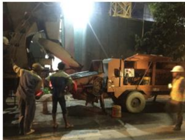
Công tác bơm bê tông
