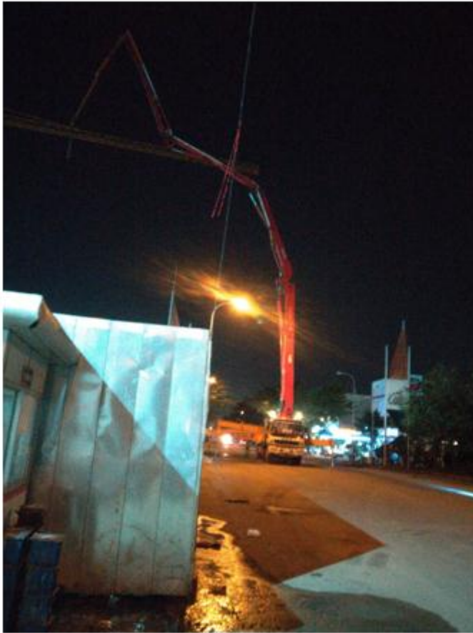
Công tác bơm bê tông
