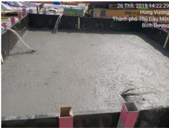
Làm mặt bê tông
