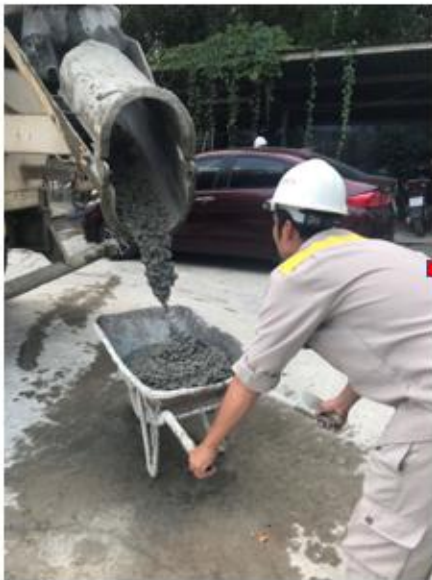
Lấy bê tông
